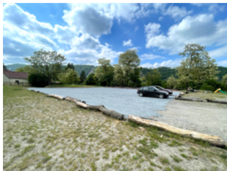
Podařilo se! Díky nákladnému vyspádování a zpevnění parkovací plochy jsme se snad konečně zbavili louží.
