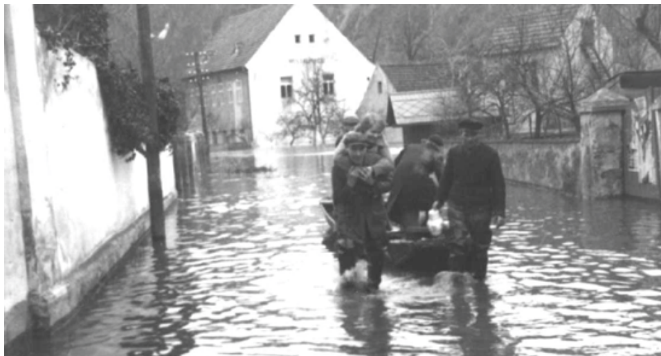
Velká voda na silnici mezi přívozem a papírnou, 1940. Zdroj: archiv Petra Novotného
