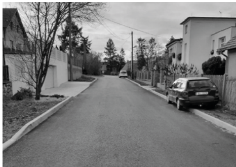
Komunikace v ulici Na Vršku a Spojovací
