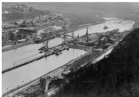
Výstavba elektrárny a plavebních komor. Vltava je převedena do místa budoucích jezových polí. Archiv Povodí Vltavy
